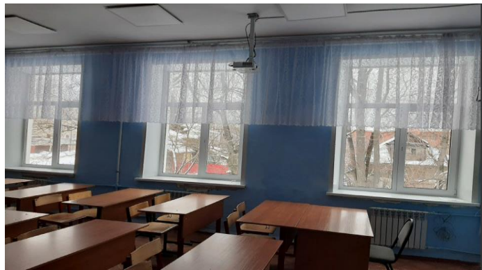
Замена оконных блоков школа №3
