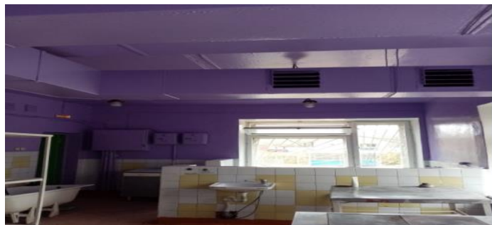
Ремонт пищеблока детский сад 6
